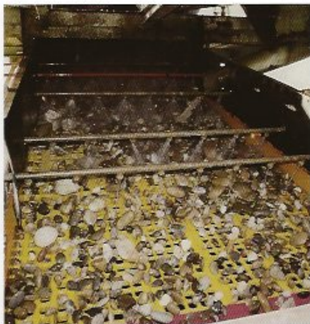
WS 85 in der Kiesaufbereitung
