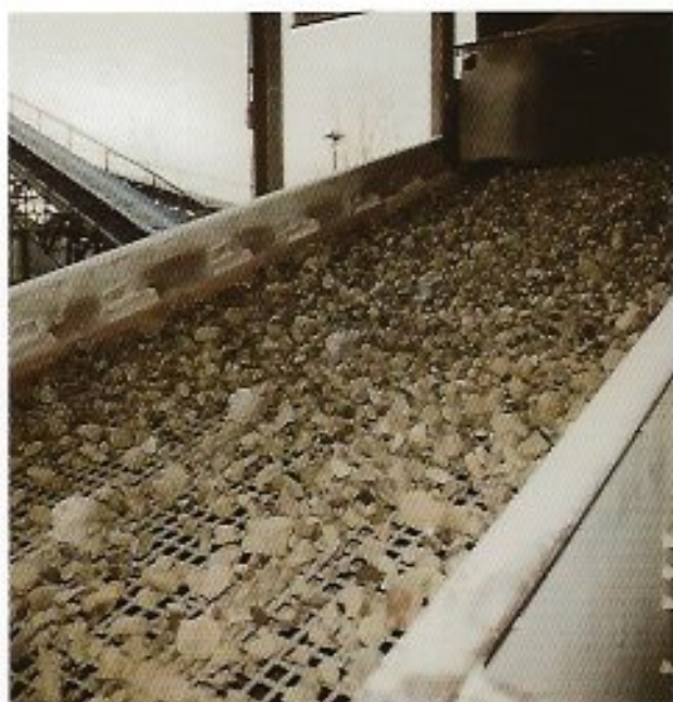
Drahtsiebe in der Schotteraufbereitung
